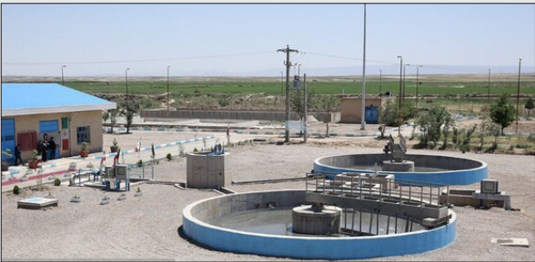
پیشرفت سازه‌های تصفیه‌خانه، تجهیز آن را نیز با سرعت بیشتری پیش خواهیم برد.
