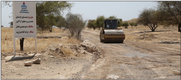
بتنی با دهانه‌های ۲ و ۴ متری،احداث کانال سنگی به طول ۳۰۰۰ متر،ساخت دیوار حائل
